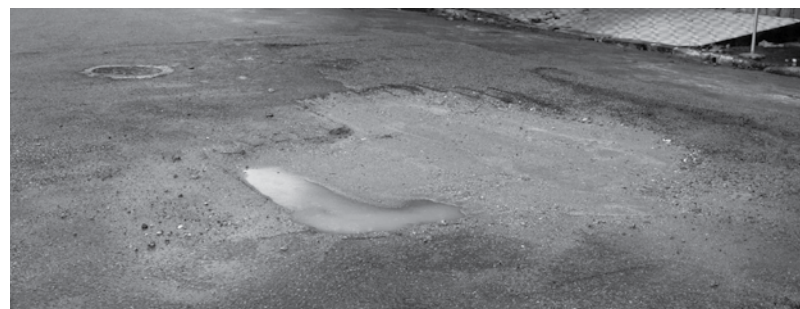
Reparo feito no asfalto durou menos de um mês. Foto: Nicole Doná
