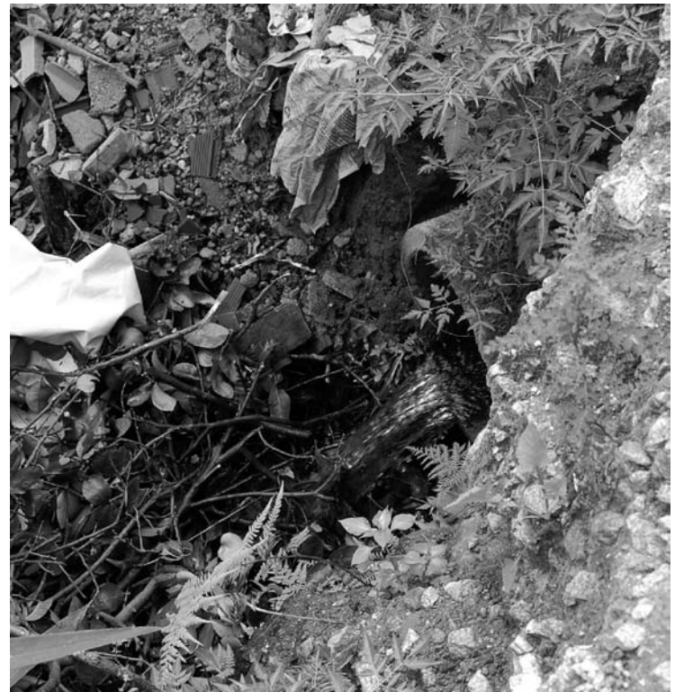
Desastre anunciado, uma início de uma erosão sobre outra galeria a cerca de 100 metros da cratera (à esquerda)
